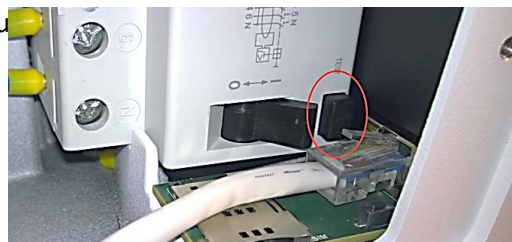
Slika 34: Gumb za testiranje FID sklopke (RCD)
